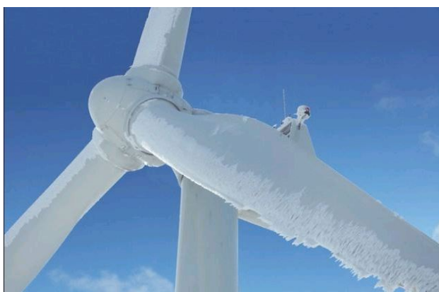
Figur 1: Ekstrem ising på vindturbin
