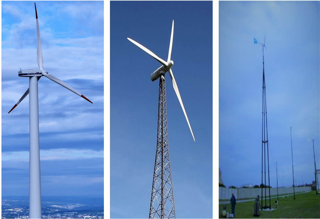
Figur 17.2: Konisk sylindermast, fagverksmast og trebeint mast. De to førstnevnte er de mest utbredte masttypene
